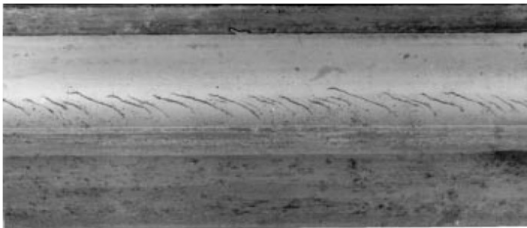
Obrázek 23 - šikmé trhliny pojížděné hrany (head checking)
