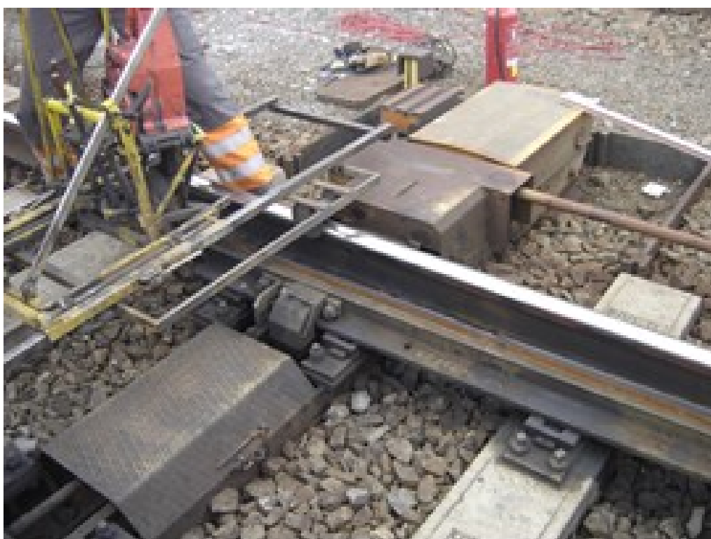
Obrázek 57 - odrolený jazyk před broušením
