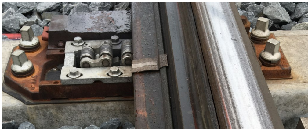
Obrázek 6 - válečková integrovaná stolička – typ SVV-P
