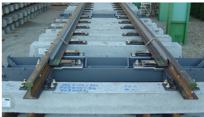
Obrázek 19 – výměna na betonových pražcích
