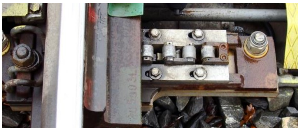
Obrázek 8 - válečková stolička na 1. žlabový pražec, typ SVV-ZP
