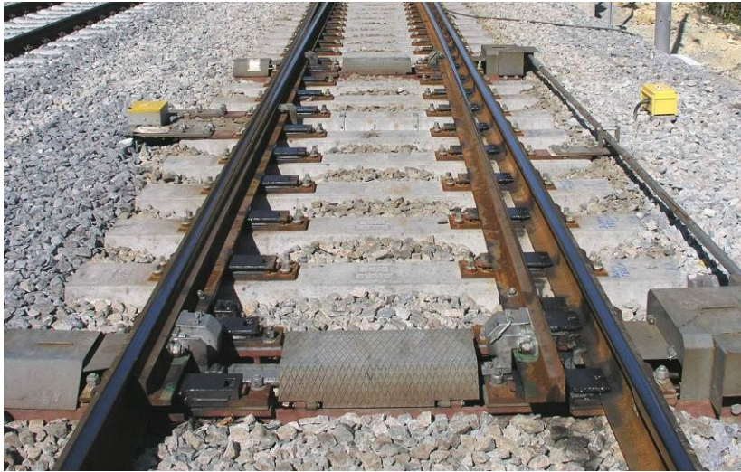
Obrázek 1 - výměna jednoduché výhybky
